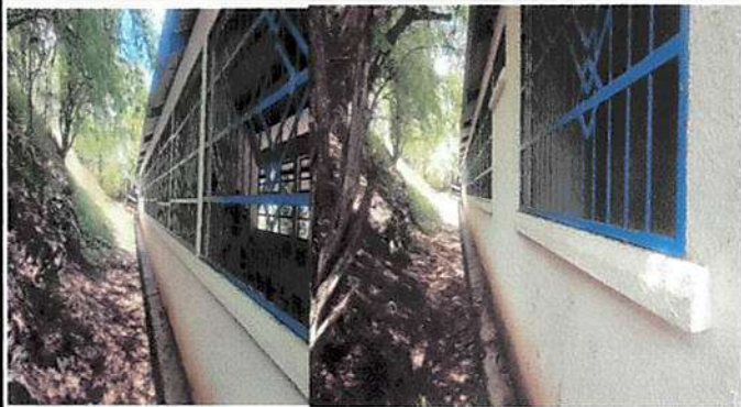
Foto1: Instalación de ventanas de PVC.
