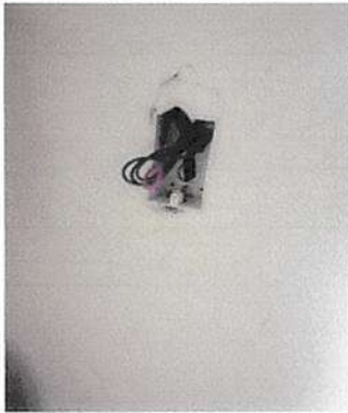
Foto 3: Mejoramiento y restauración de Sistema electrico del centro educativo
