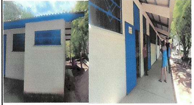
Foto 2: Sustitución de pintura interior y exterior del centro educativo.
